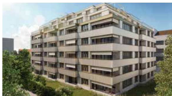
ZÜRICH – Umnutzungsprojekt, Badenerstrasse 701
