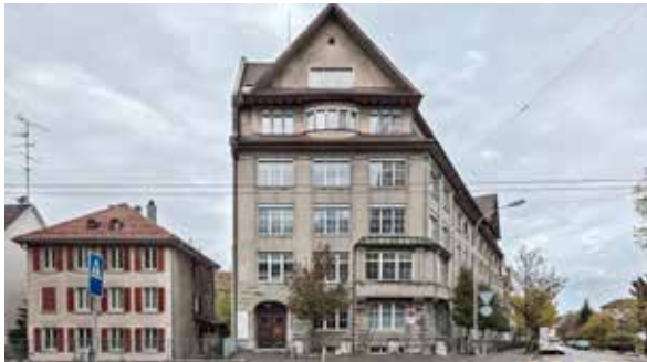
St. Gallen, Rorschacherstrasse 139, Helvetiastrasse 27
