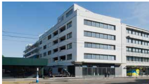
Zürich, Badenerstrasse 696, J. Fügli-Strasse 16, 18, Bachmattstrasse 53
